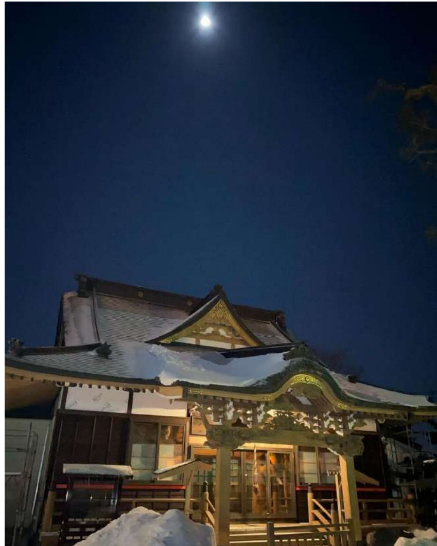
改修中の本堂(スノームーン前日)
